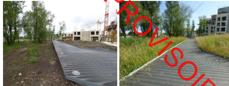
Voie piétonne en platelage bois en phase travaux (à gauche) et en phase d'exploitation (à droite)
