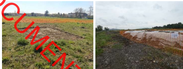
Exemples de station floristiques après décapage des horizons superficiels et merlon de stockage des banquettes de terre (Source : Simethis)
