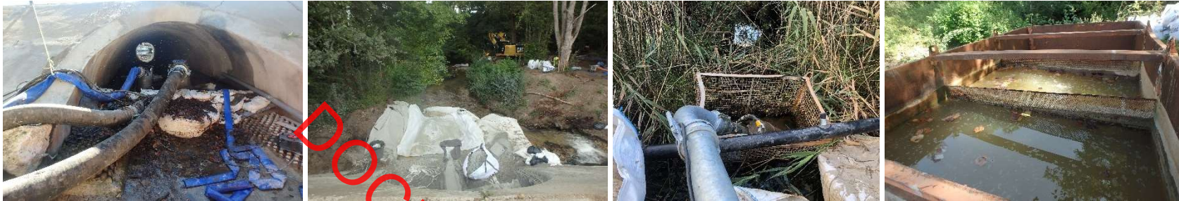
Exemple de batardeau amont, de batardeau aval, de cage autour de la pompe immergée et bac de décantation
