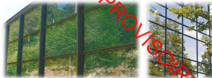
Figure 20 : Verre réfléchissant et plantations trop proches du bâtiment ; les oiseaux perçoivent le reflet des arbres et croient pouvoir s'y réfugier, ils percutent alors la vitre (Source : « Les oiseaux, le verre et la lumière dans la construction » - H.Schmid, P.Waldburger, D.Heynen – ASPAS, 2010)
