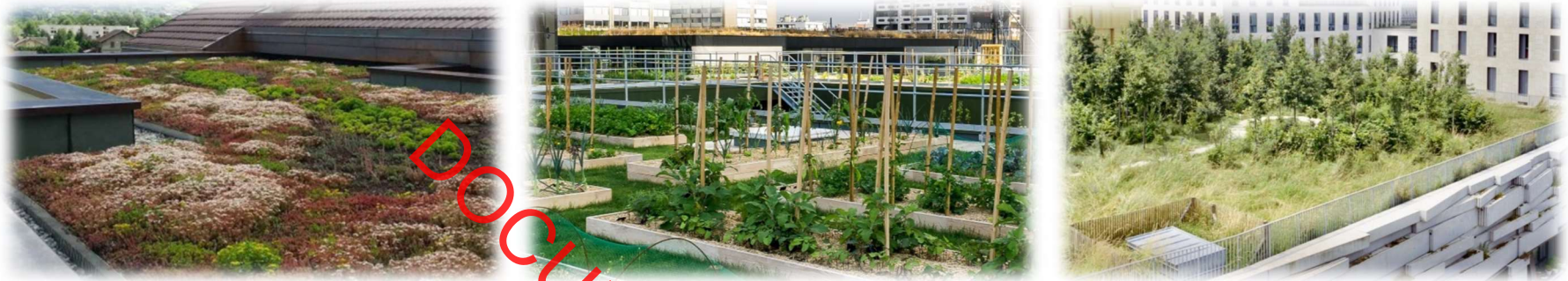
Figure 18 : Exemple de toitures végétalisées : toit extensif (à gauche), toit semi-intensif (au centre) et toit intensif (à droite) (Source : https://www.jardin-naturel.fr/toiture-vegetale/ , https://www.ecovegetal.com/comment-concevoir-un-potager-sur-le-toit/ , https://terrassetjardindepatis.com/paysagiste/toiture-vegetale/ )
