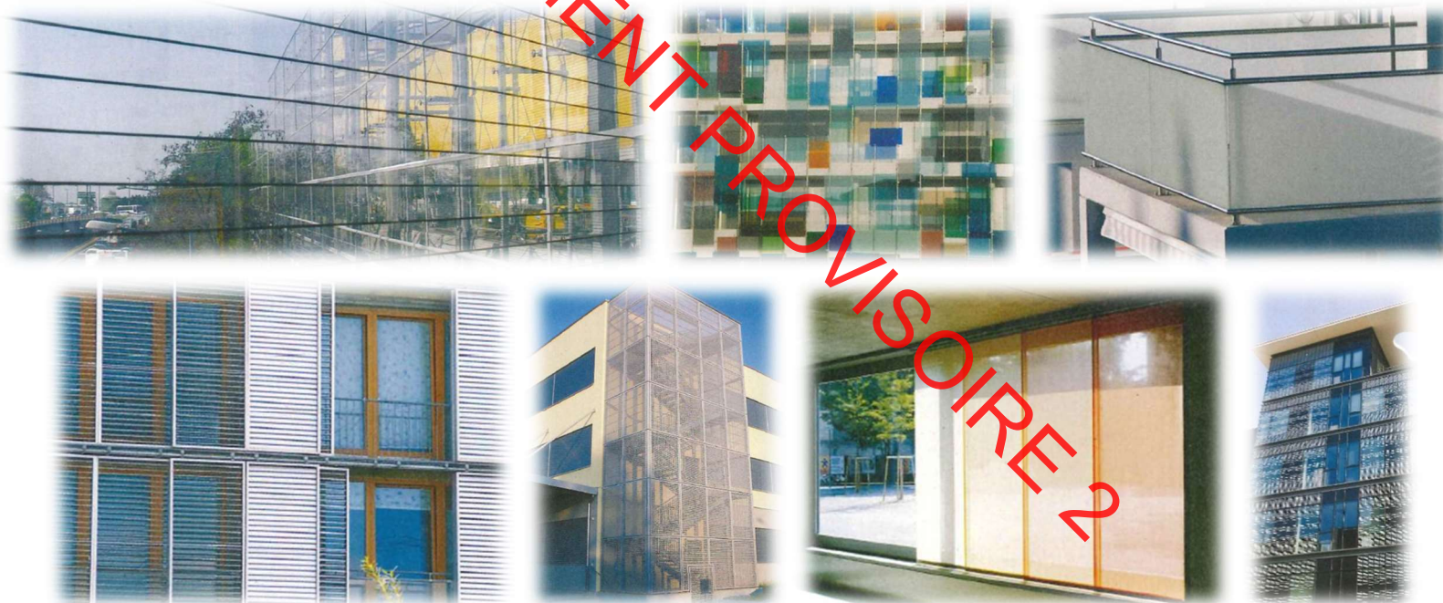
Figure 21 : Exemples de façades vitrées compatibles avec l'avifaune : de gauche à droite et de haut en bas : trame de ligne, verre coloré, balustrade translucide, store déplaçable latéralement, treillis métallique, rideaux fixés à l'intérieur, motifs appliqués (Source : « Les oiseaux, le verre et la lumière dans la construction » - H.Schmid, P.Waldburger, D.Heynen – ASPAS, 2010)
