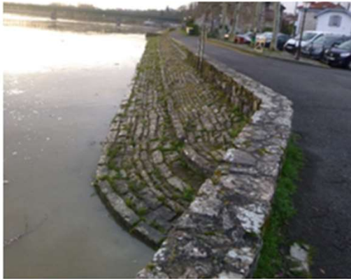
Berge bétonnée avec végétation rudérale
