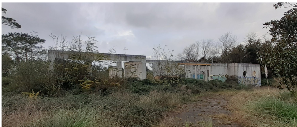
Les « ruines » de la villa inachevée autorisée en 2011 (Source :Michel Cazaubon)
