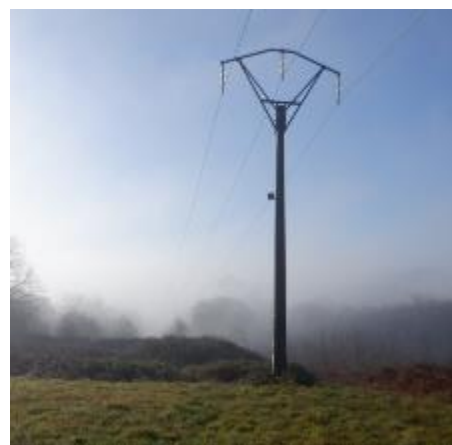
Vue sur la ligne aérienne et un pylône sur la parcelle AK n° 197. Source : APGL.
