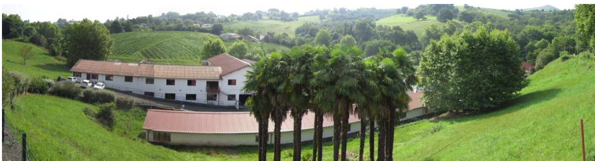
Vue sur une partie des bâtiments de la tannerie depuis la RD249, juillet 2020. Source : APGL, SITU.
