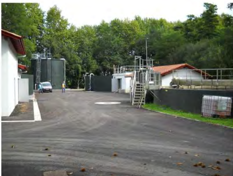
Figure 15: Vue de la station d'épuration
