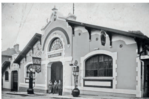
Garage Marcel Daverat, 95 rue Maubec.
